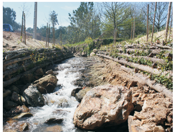
Figura 23: Parede krainer simples em talude. Desenho de Venti et al. 41 e fotografia de Rita Sousa (2011).
