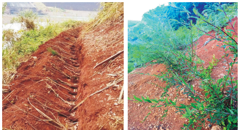
Figura 16: Evolução de uma intervenção utilizando banquetas vegetadas. Fotografias de Rita Sousa (2016, 2017).
