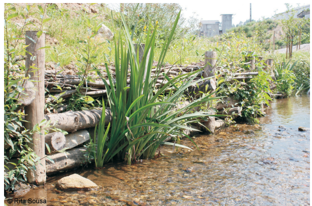
Figura 25: Parede krainer modelo fluvial, com prumo frontal. Desenho adaptado de Venti et al. 43 e fotografia de Rita Sousa (2011).
