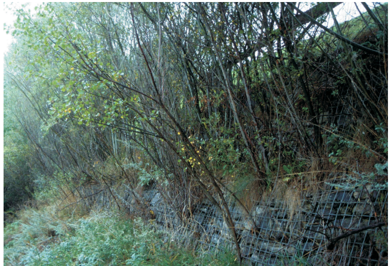
Figura 26: Gabião vivo. Esquema construtivo (acima) e gabião com vegetação estabelecida (abaixo). Desenho de Helgard Zeh 44 e fotografia de Florin Florineth (2004) 45 .
