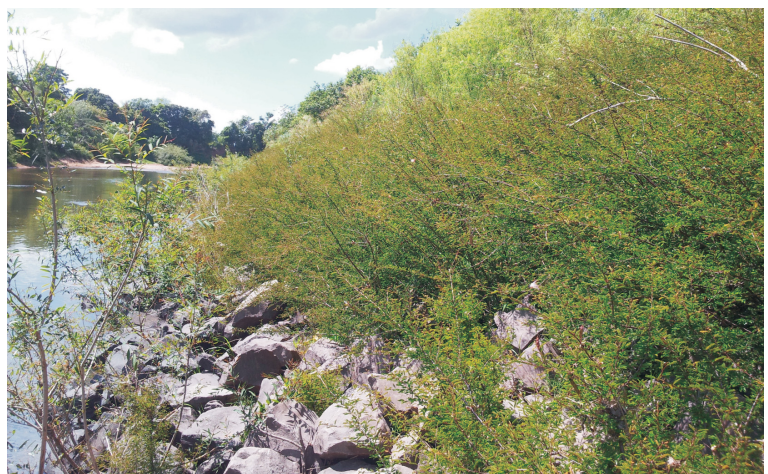
Figura 17: Enrocamento com vegetação em fase de desenvolvimento inicial. Desenho de Eubanks & Meadows 37 e fotografia de Fabrício Sutuli (2012).
