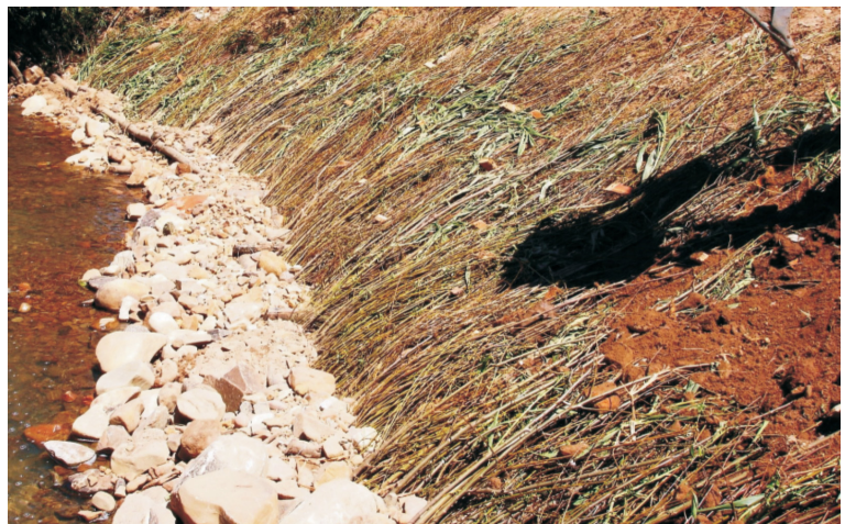
Figura 14: Construção de esteira viva. Fotografia de Fabrício Sutili (2004).
