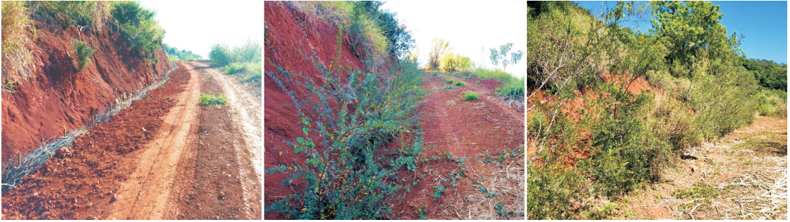
Figura 11: Evolução de uma intervenção utilizando feixes vivos aplicada para drenagem de taludes. Fotografias de Rita Sousa (2016, 2017 e 2019).
