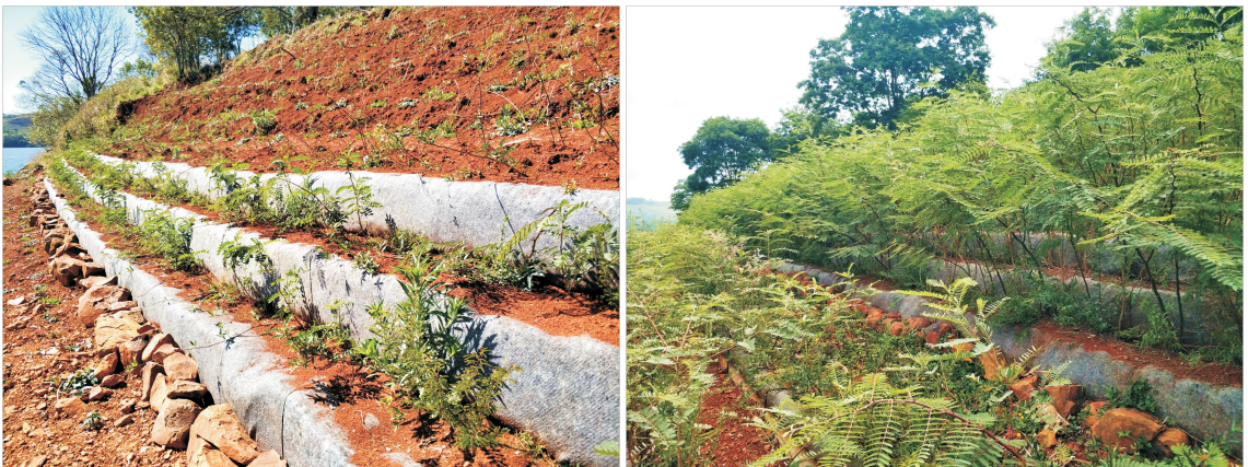
Figura 28: Evolução de uma intervenção com solo envolvido em talude. Fotografias de Rita Sousa (2021).
