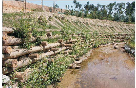
Figura 24: Parede krainer dupla em talude. Desenho adaptado de Venti et. al. 42 e fotografia de Rita Sousa (2011).
