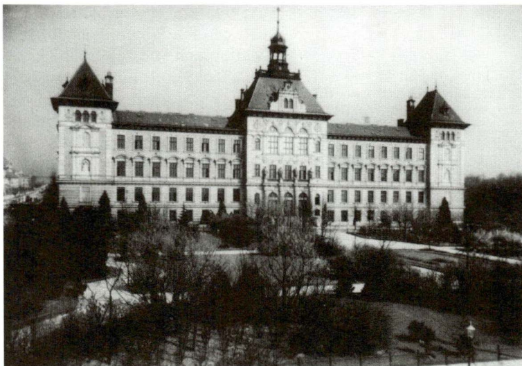
Vista do prédio da reitoria da Universidade Rural de Viena, no início do século XX.
