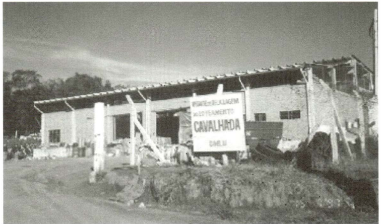
Figura 7 Vista geral da Unidade de Triagem Cavalhada.
