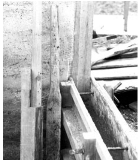
Detalhe da forma e sua fixação no pilar pré-moldado de concreto.
