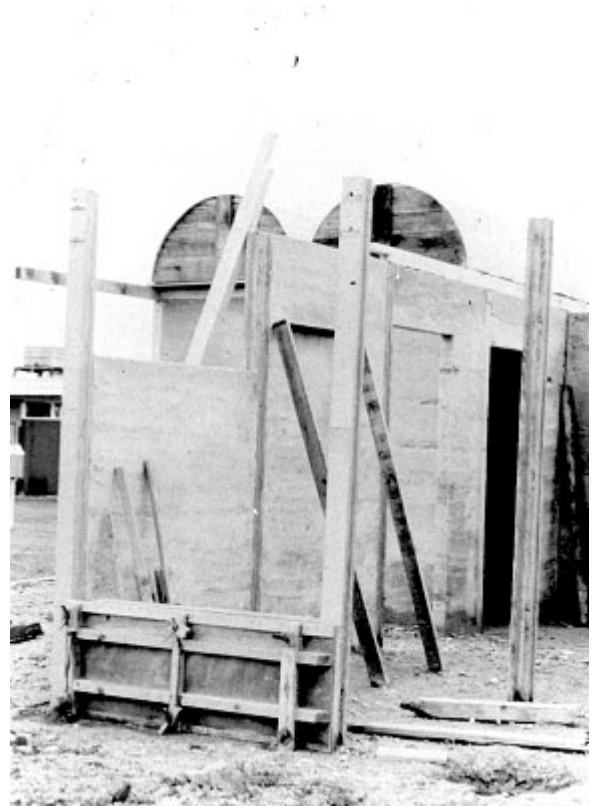
Detalhes das junções de paredes com pilares de concreto pré-moldado e o muro “Tromb”.
