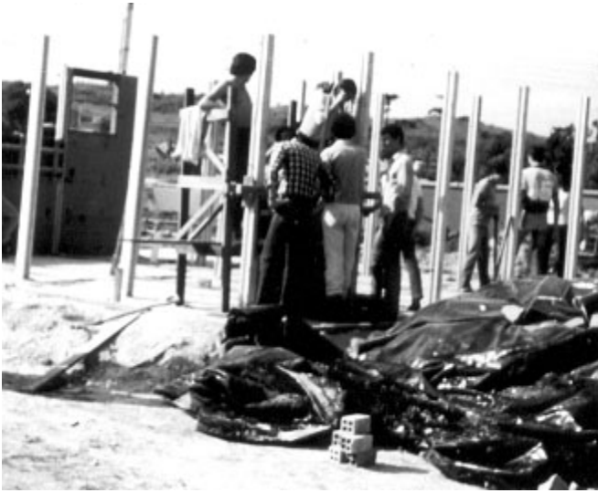
Execução das paredes da habitação bioclimática pelos estudantes da PUC/PR.
