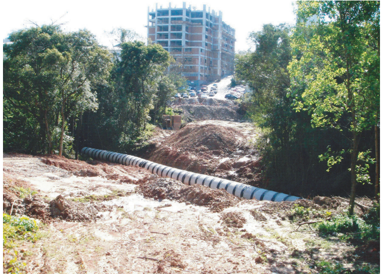
Figura 8: Canalização da Sanga do Hospital para futuro arruamento. (Fotografia: Fabrício Sutili)
