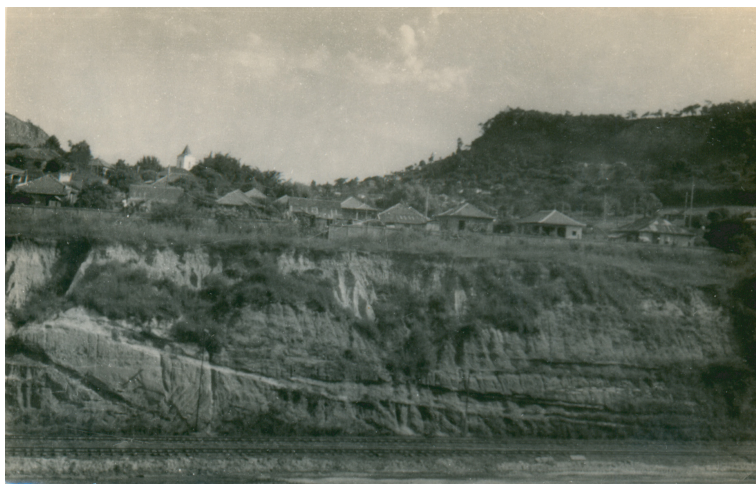
Figura 7: Formação Caturrita, com estrutura de corte e preenchimento de canal fluvial, contendo troncos vegetais petrificados, na altitude de 135 m. Corte do viaduto da ferrovia, na rua Euclides da Cunha. Em segundo plano, vista parcial do flanco oeste do Cerro de Santa Maria com topo tabular, recoberto pelo primeiro derrame de basalto (Fotografia: C. A. Bortoluzzi, 1971).
