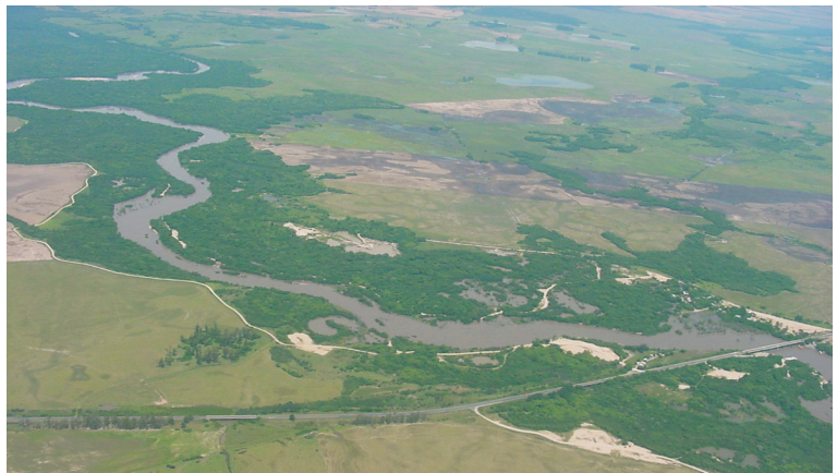
Figura 13: Vista aérea da ponte sobre o Rio Vacacaí, que estabelece o limite sul do 6º Distrito do Passo do Verde com o município de São Sepé. Depósitos de areia na planície aluvial do rio, nas proximidades da ponte da BR-392, mostram a sua extração econômica. Foto obtida em 22/11/2003, quando o canal fluvial estava totalmente preenchido, em razão da alta pluviosidade que vinha acontecendo. (Fotografia: Pedro Sartori, 2003)
