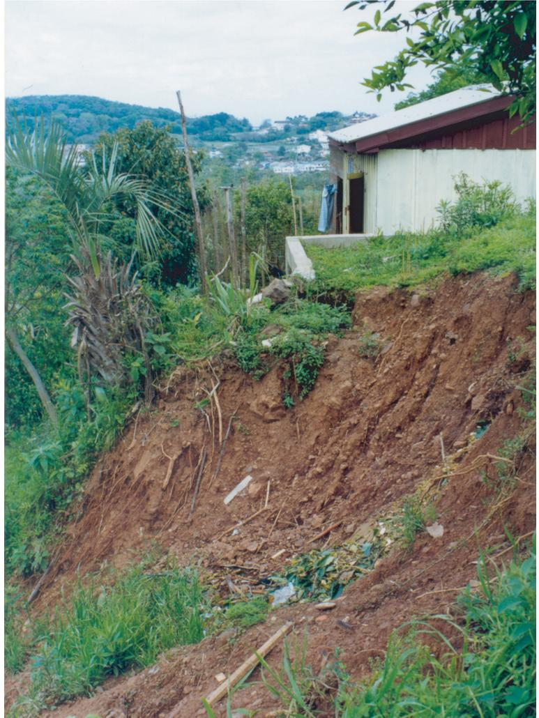
*Figura 11:* Depósito coluvionar de encosta da Serra Geral, na Vila Bilibio, sobre o qual foram construídas casas de moradia. (Fotografia: Pedro Sartori, 2000)
