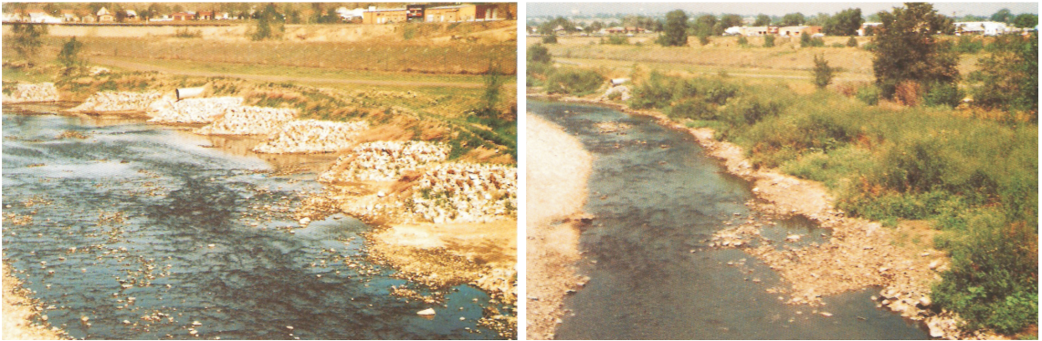
Figura 5: Râmprolas de pedras (vegetadas com sementes e estacas) para direcionar o fluxo de água para o centro e evitar a corrosão marginal. Esquerda: logo após construção. Direita: após dois meses. Fotografia: R. Sotir Marietta, Georgia U.S.A.
