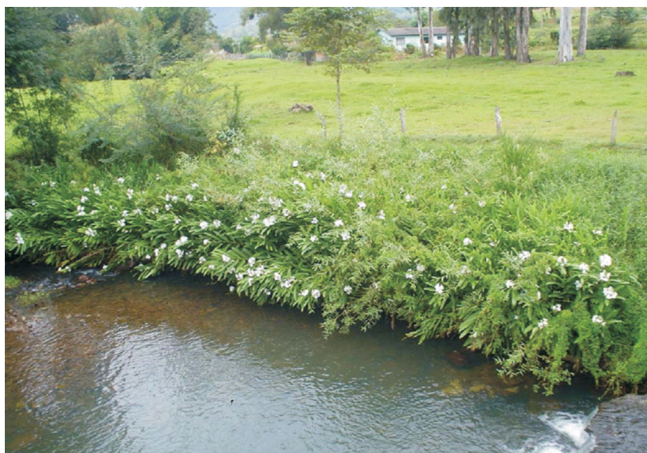
Sequência de recuperação do Arroio Divisa em Vale Vêneto (São João do Polêsine, RS), usando esteira viva. Fotografias: Fabrício Sutili e Miguel Durlo
