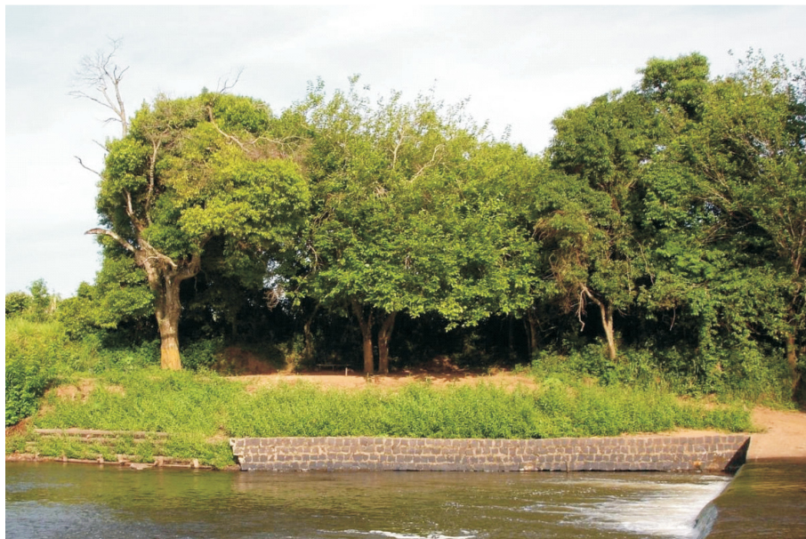
Sequência de recuperação de um trecho da margem do Rio Soturno (Faxinal do Soturno, RS), usando esteira viva e parede Krainer. Fotografias: Fabrício Sutili e Miguel Durlo
