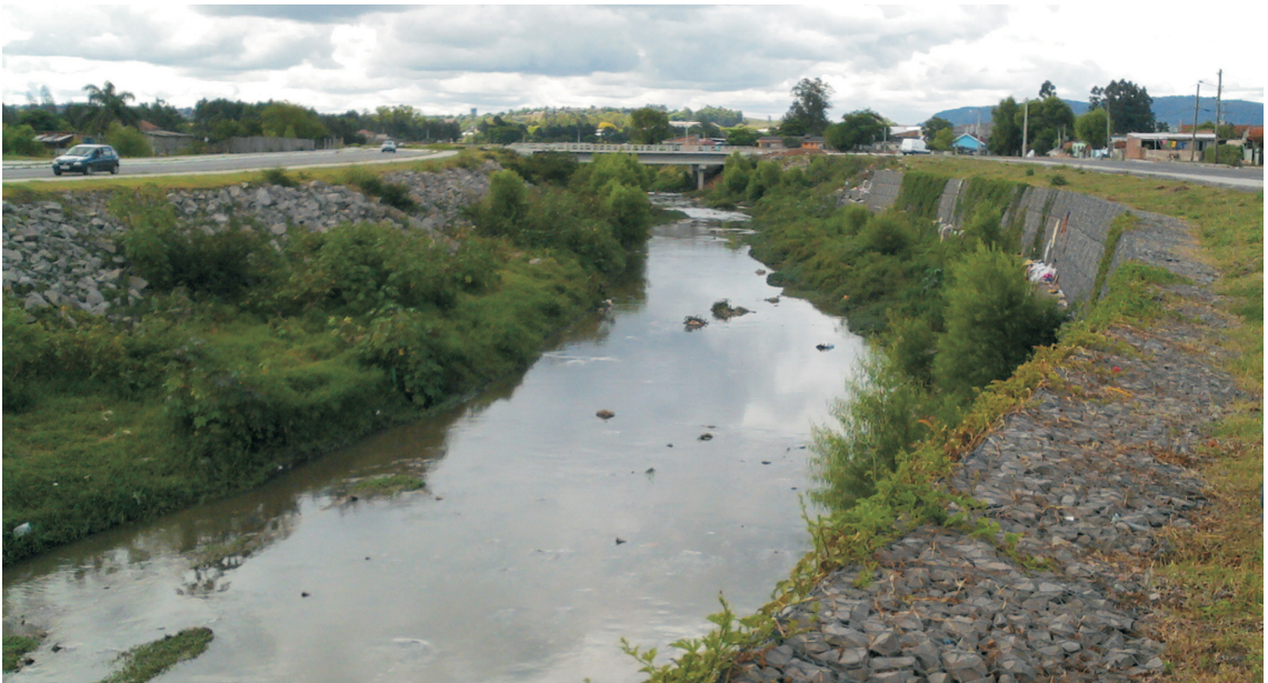
Figura 9: Gabiões sendo recobertos pela vegetação no arroio Cadena, Santa Maria, RS. Fotografia: Alexandre Dal Forno Mastella
