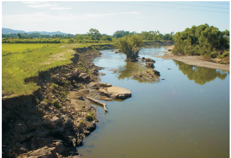
Figura 1: Margem do Rio Soturno (Faxinal do Soturno, Rio Grande do Sul, RS) após enchente. Observação: a margem original correspondia à posição da touceira de taquara, agora no centro do curso. Essa situação causa turbilhonamento e desvios do fluxo, nos períodos mais chuvosos, destruindo a margem esquerda e depositando materiais na margem direita. Fotografia: Miguel Durlo
