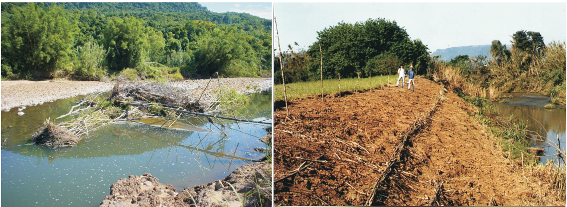
Figura 3: Touceiras de taquaras impedindo o livre fluxo da água no Arroio Guar-Mor, Faxinal do Soturno, RS (esquerda). Trecho de talude fluvial remodelado no Rio Mello, Faxinal do Soturno, RS (direita). Fotografias: Fabrício Sutili
