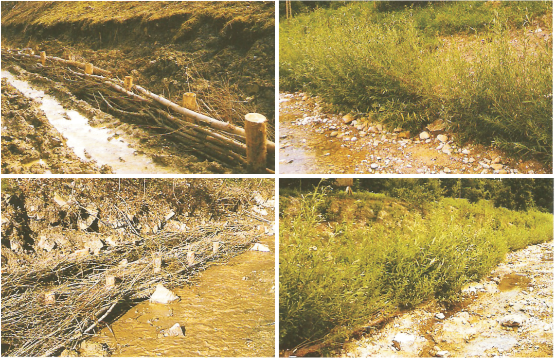
Figura 8: Acima: Trança viva após construção (esquerda) e após 4 meses (direita). Abaixo: Cilindros vivos após construção (esquerda) e após 4 meses (direita). Fonte: Florineth, F. 5
