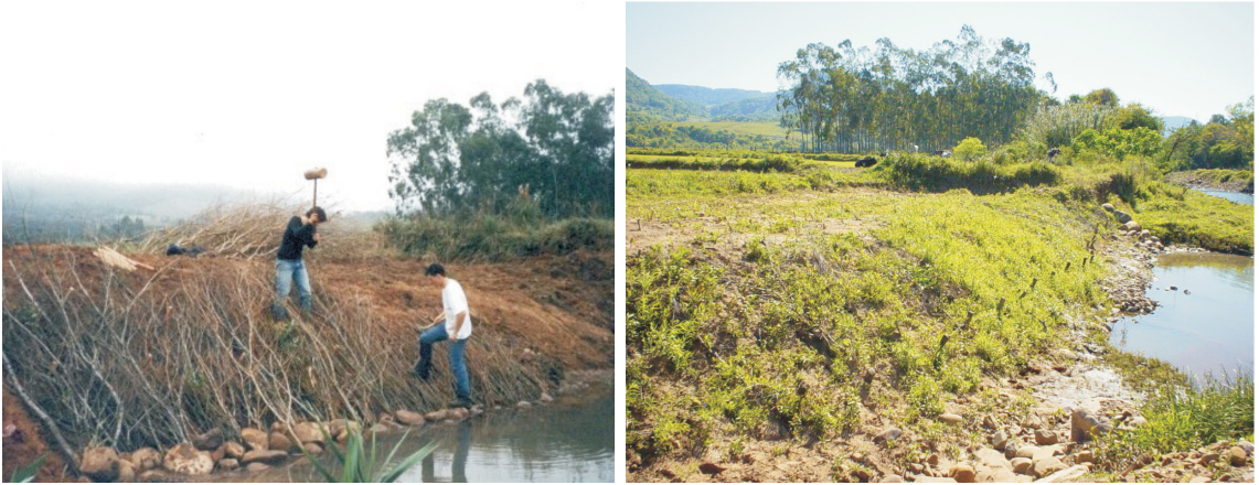
Figura 7: Esteira viva em construção e após dois meses. Rio Mello, Faxinal do Soturno, RS. Fotografia: Fabrício Sutili
