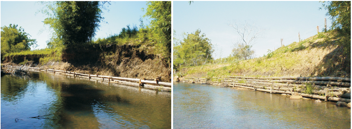
Figura 4: Revestimento da margem com material inerte (madeira) e vegetação: “Parede Krainer” simples. Esquerda: em construção. Direita: após 30 dias. Arroio Guarda-Mor, Faxinal do Soturno, RS. Fotografia: Fabrício Sutili
