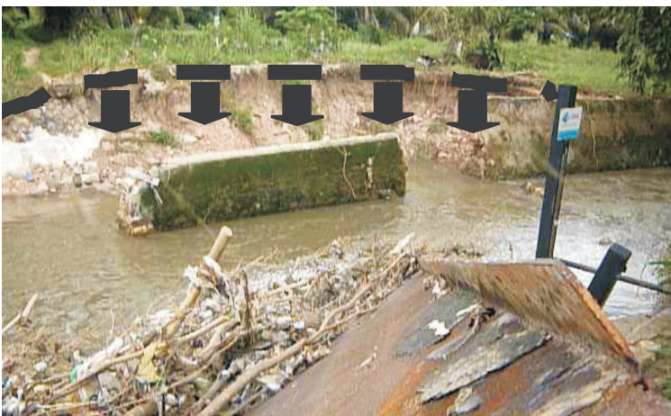
Figura 6: Foto do Igarapé do Mindu, na seção de réguas, onde se vê área da planície fluvial retomada pelo rio a despeito do canal de concreto e ponte que foi destruída pela enxurrada
