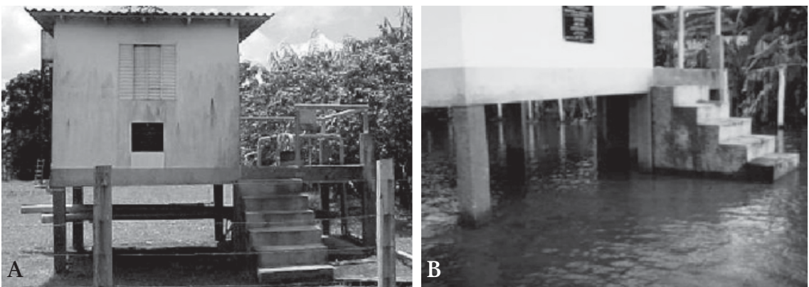
Figura 1: Adequação para cheias: boca de poço e casa com sistema elétrico elevado em zona da várzea do Rio Amazonas, evitando entrada de água e danos. A: estiagem. B: cheia.
