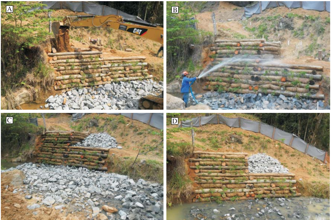
Figura 16: Execução da parede krainer e do perfil de compensação.
