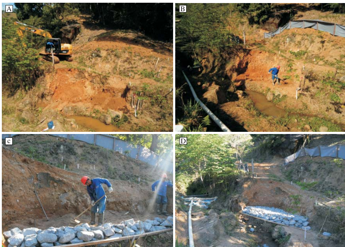
Figura 13: Preparação da base para a parede krainer. Processo de escavação (a, b) e preparação da base em enrocamento para assentamento da parede krainer (c, d)
