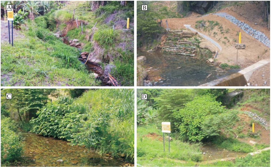
Figura 18: Evolução da obra de Engenharia Natural
