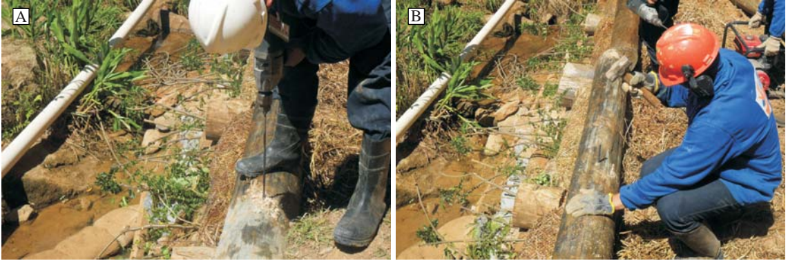
Figura 15: Detalhes da fixação dos troncos da parede krainer
