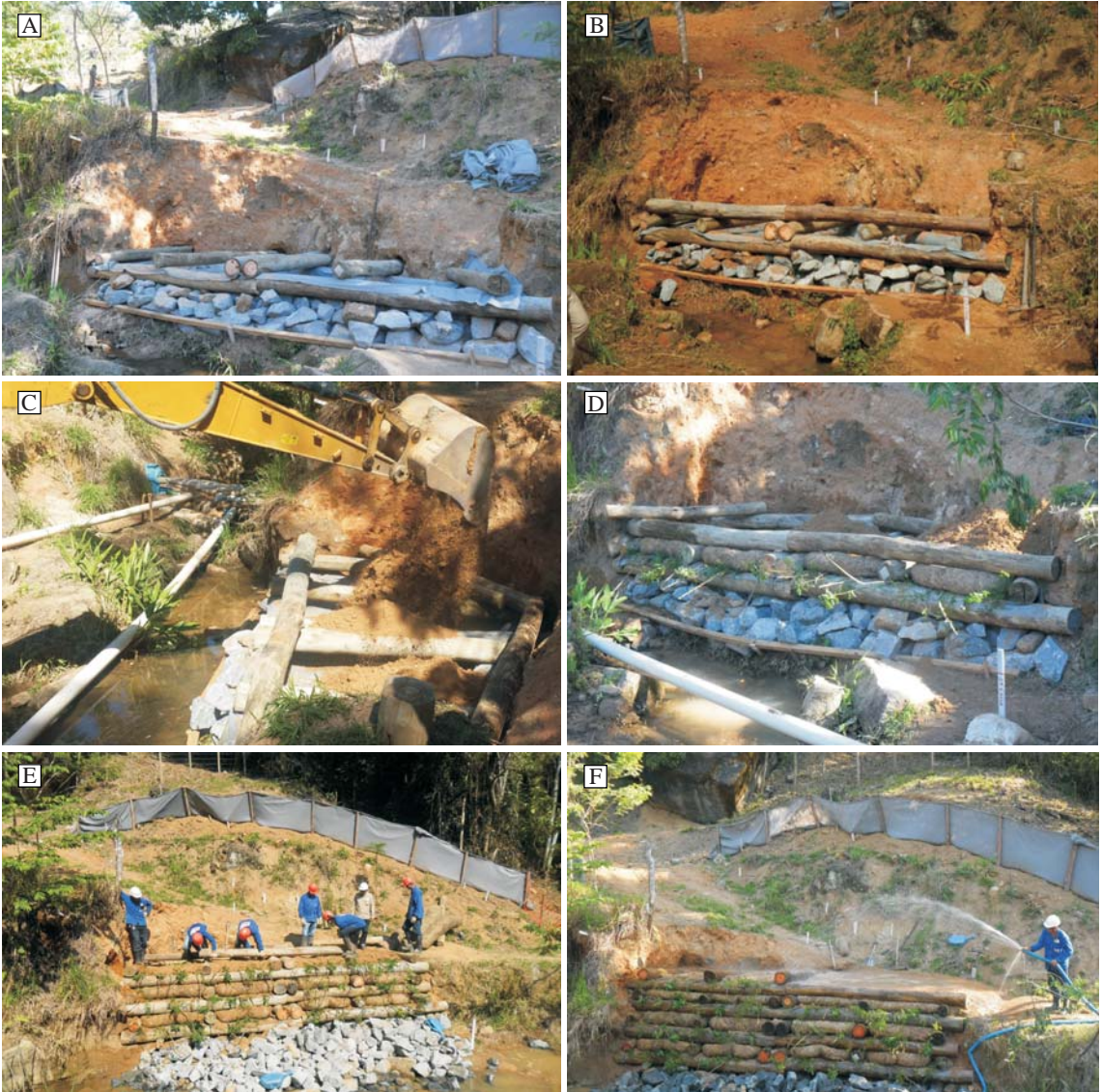
Figura 14: Execução da parede krainer
