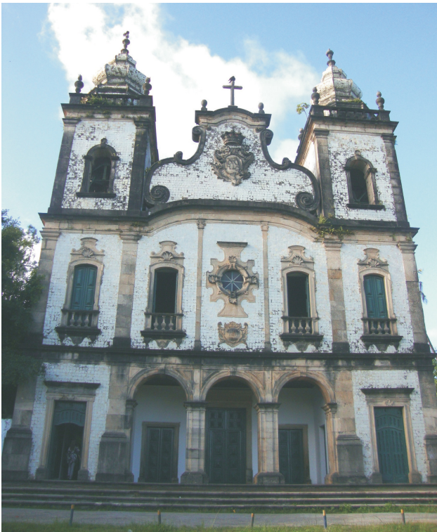
Fachada da Igreja Nossa Senhora dos Prazeres. Foto: Sandra Bernardes Ribeiro, 2012.
