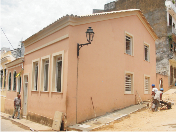
Figura 7: Edificação recuperada na Rua São Francisco
