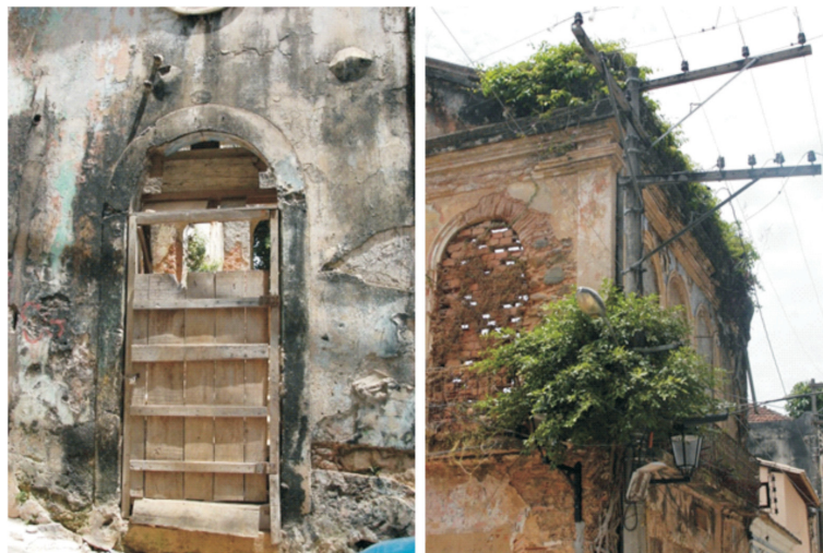
Figura 4: Situação dos casarões antes das obras
