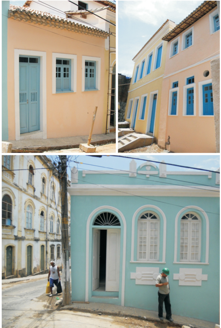
Figura 5: Casarões da 7ª Etapa após obras de recuperação
