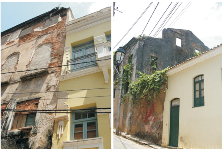
Figura 8: Edificações recuperadas encostadas em edificações ainda arruinadas
