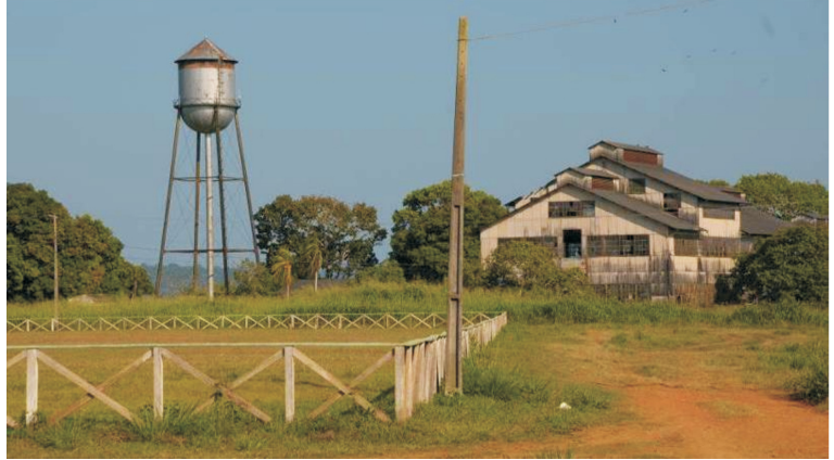
Vista atual da caixa d'água, à esquerda, e antiga serraria, à direita. Foto: Chikaoka
