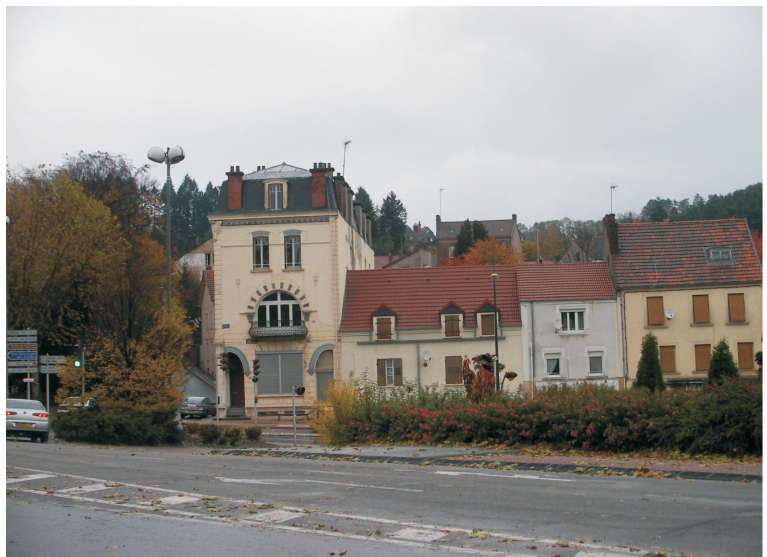
Le Creusot, maison d'ingénieur aux tuiles d'ardoise à l'extrémité d'une rue de maisons d'ouvriers aux tuiles de terre cuite.
