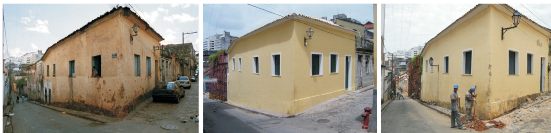
Figura 9: Edificação antes e depois da recuperação na Rua 3 de Maio
