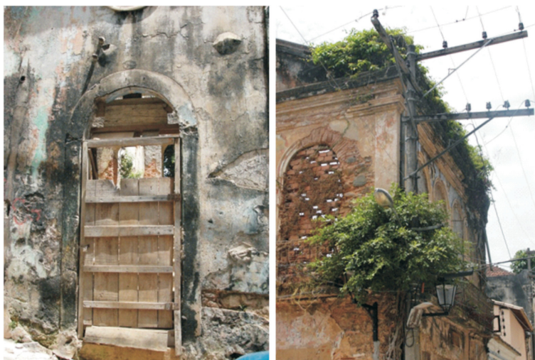
Figura 4: Situação dos casarões antes das obras
