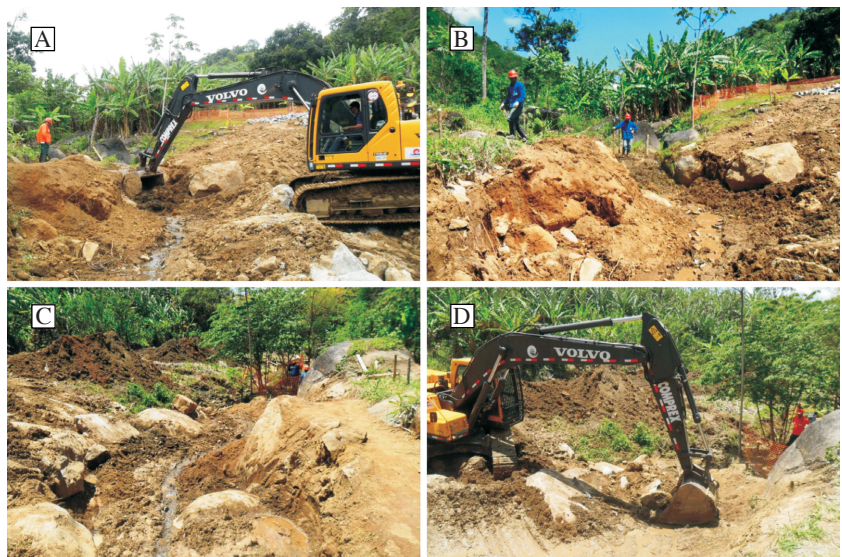
Figura 14: Reconformação do novo leito e margens após desmonte de rochas.
