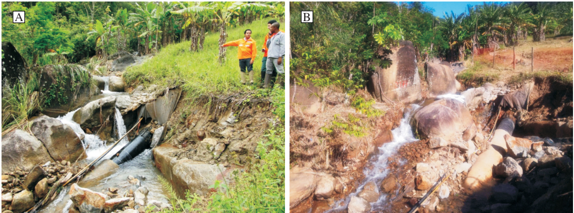
Figura 3: Aspectos do canal junto ao duto. As imagens A e B mostram um canal alterado pela energia do fluxo da água. Leito e margens escavados, fragmentos de rochas de grandes dimensões arrastados e margens com inclinações acentuadas. A estabilidade da faixa foi prejudicada e a segurança do duto, exposto juntamente com a fibra óptica, poderia ser comprometida se o processo persistisse.
