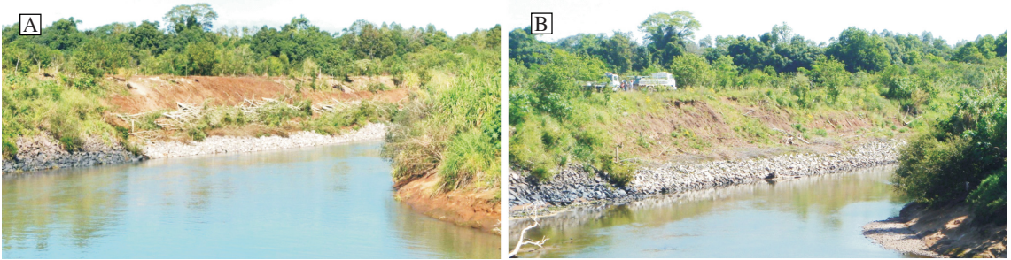
Figura 13: A) Vista geral do talude após a execução da primeira fase da obra (Abril/2010). B) Vista geral do talude após os eventos de enchente que removeram o espigão de árvores de E. contortisiliquum (Agosto/2010).
