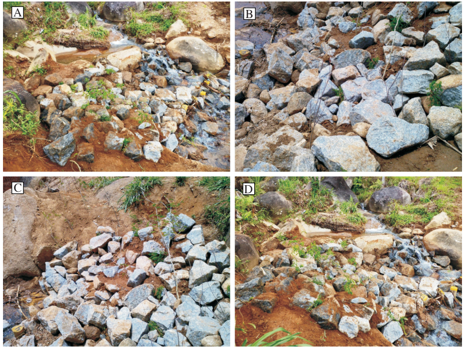
Figura 18: Enrocamento vivo finalizado.
