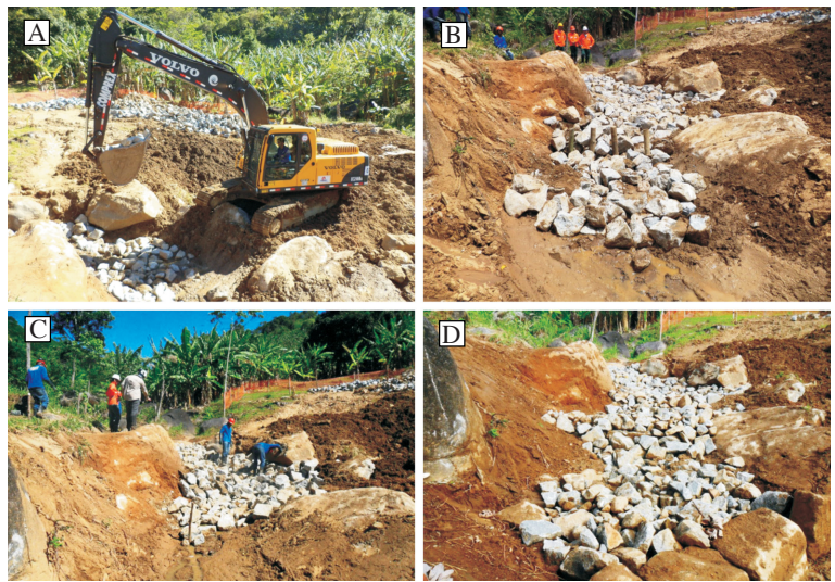
Figura 16: Execução do enrocamento do leito do curso de água.
