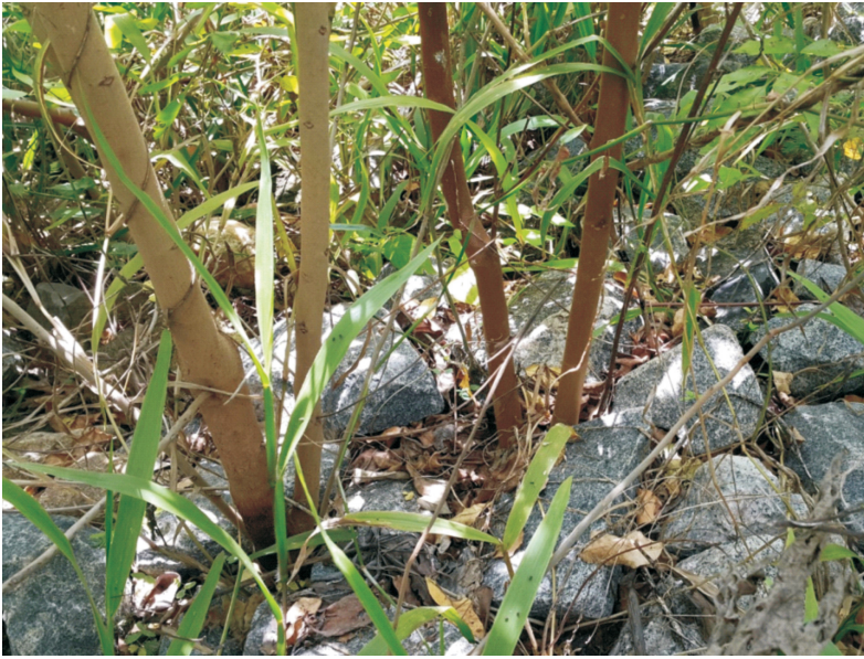
Figura 20: Detalhe do desenvolvimento das plantas no enrocamento.
