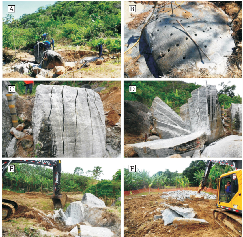
Figura 13: Processo de desmonte e retirada de rochas para reformulação das margens e eixo da torrente.
