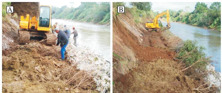
Figura 8: Execução da banquetta de arbustos. A) Colocação dos arbustos sobre a banquetta. B) Aporte de solo sobre os arbustos.
