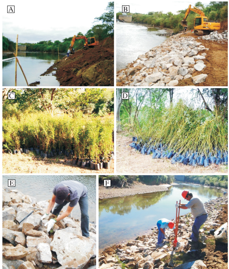
Figura 7: Execução do enrocamento vegetado. A) Retaludamento da base. B) Colocação dos blocos de basalto em toda extensão da base do talude. C) Mudanças de Calliandra brevipes utilizadas no enrocamento. D) Mudanças de Salix humboldtiana utilizadas no enrocamento. E, F) Plantio de mudas entre os blocos de rocha.
