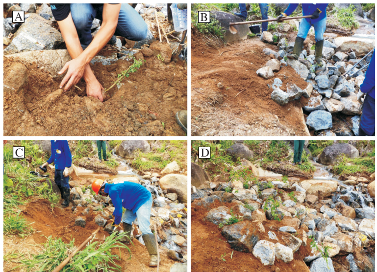
Figura 17: Execução do enrocamento vivo nas margens do curso de água.
