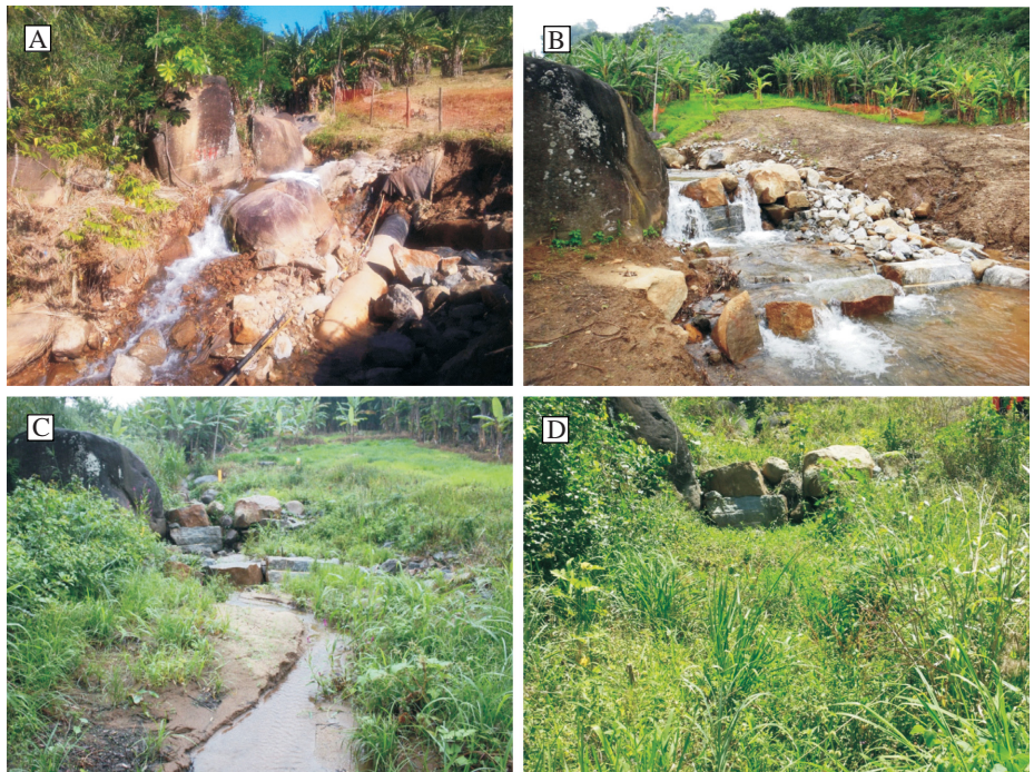
Figura 19: Evolução da obra de Engenharia Natural.
