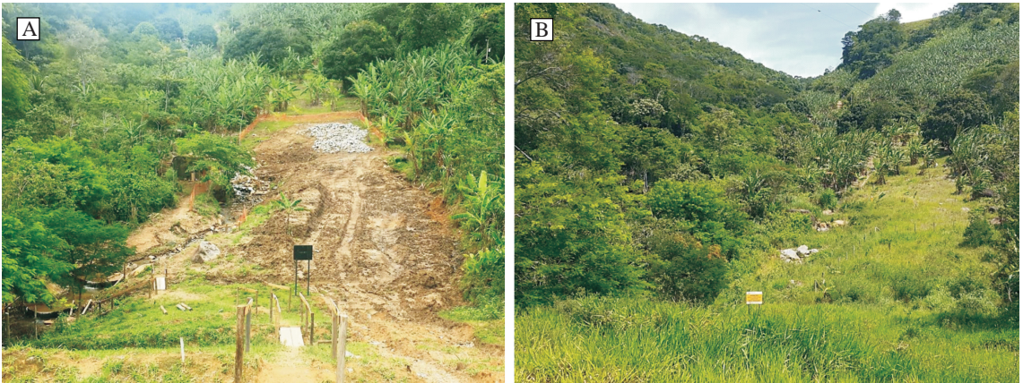
Figura 21: Vista geral da área de intervenção (fotografias de jusante para montante).
