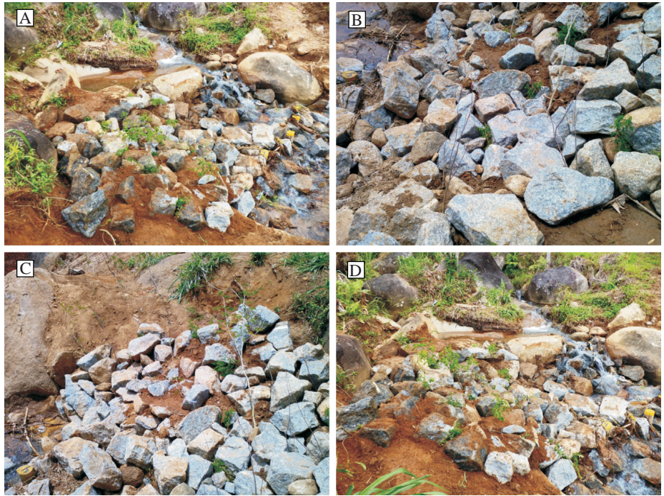
Figura 18: Enrocamento vivo finalizado.
