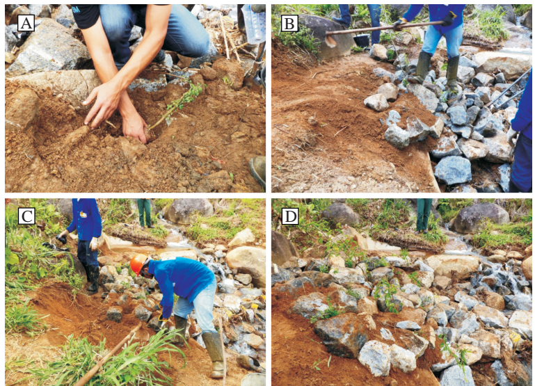
Figura 17: Execução do enrocamento vivo nas margens do curso de água.
