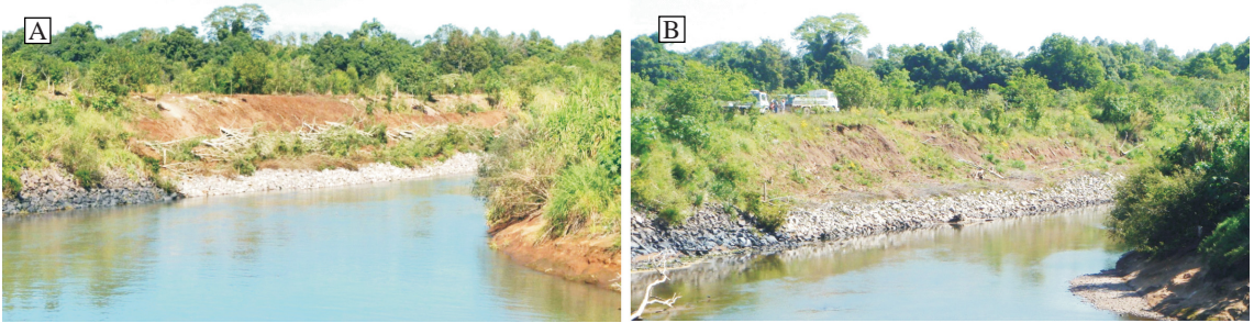
Figura 13: A) Vista geral do talude após a execução da primeira fase da obra (Abril/2010). B) Vista geral do talude após os eventos de enchente que removeram o espigão de árvores de E. contortisiliquum (Agosto/2010).
