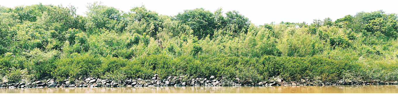
Figura 21: Vista do talude fluvial dois anos após a execução da intervenção, estabilizado e com presença de densa vegetação.
