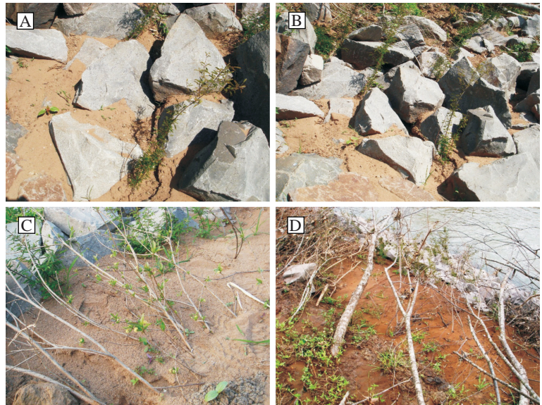
Figura 15: A, B) Depósito de sedimentos entre e sobre as rochas do enrocamento vegetado. C, D) Depósito de sedimentos entre os arbustos na banqueteta.
