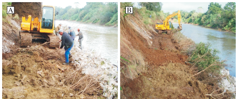
Figura 8: Execução da banquetta de arbustos. A) Colocação dos arbustos sobre a banquetta. B) Aporte de solo sobre os arbustos.
